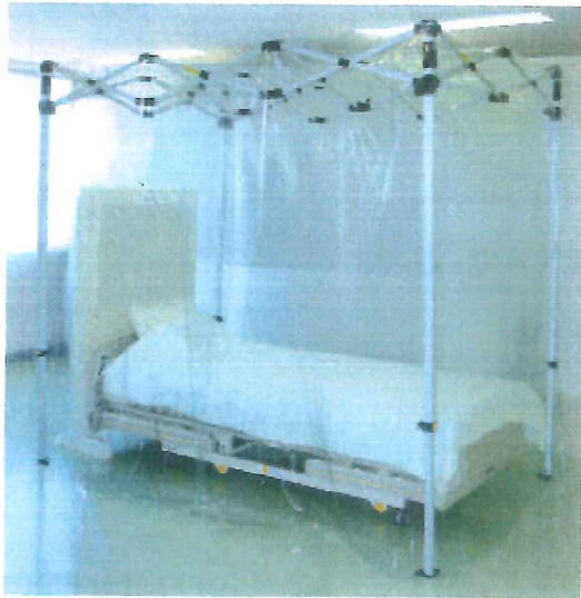
ブースをベッド周囲に移動し、クリーンパーティションを設置して完成です。
